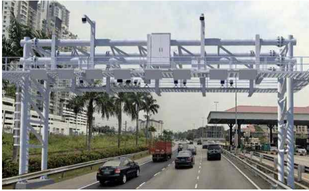
[ 그림 3-6 베스라야 KM5.5에 설치된 MLFF ]
